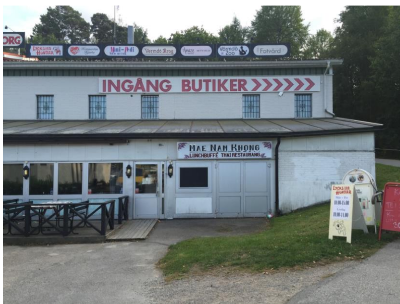
Figur 39 Butiker i gemensam byggnad i Hemmesta.
